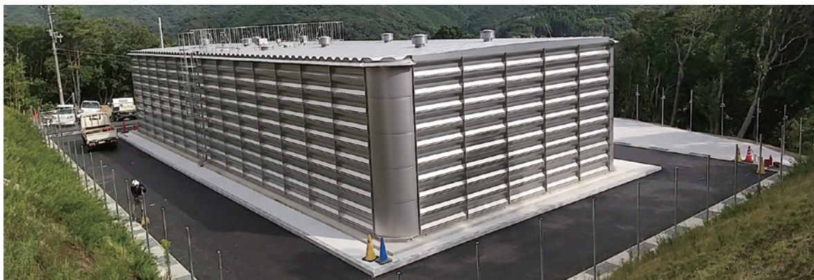
只越配水池(新設)
