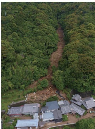
土砂崩れ（畑地区）
