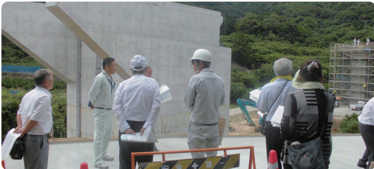
衣奈～三尾川間道路改良工事中の風景
