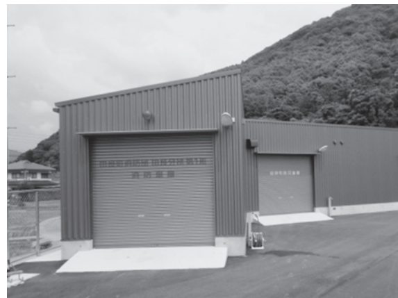
▲消防車庫及び防災倉庫外観
