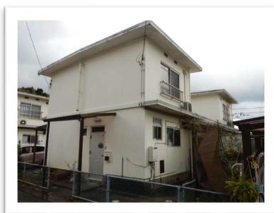
②南改良住宅
