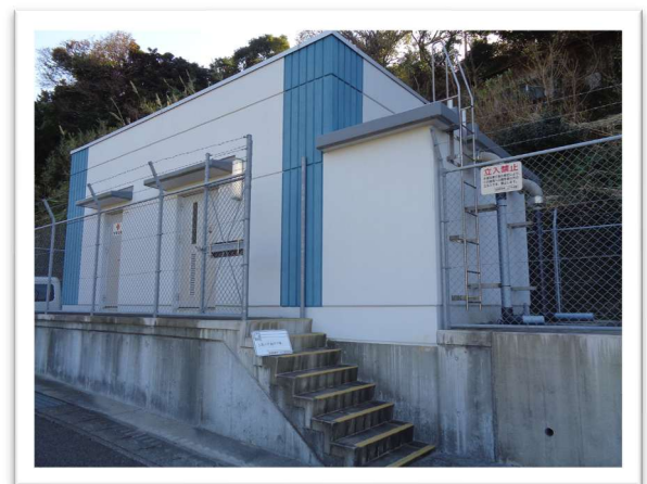
三尾川中継ポンプ場
