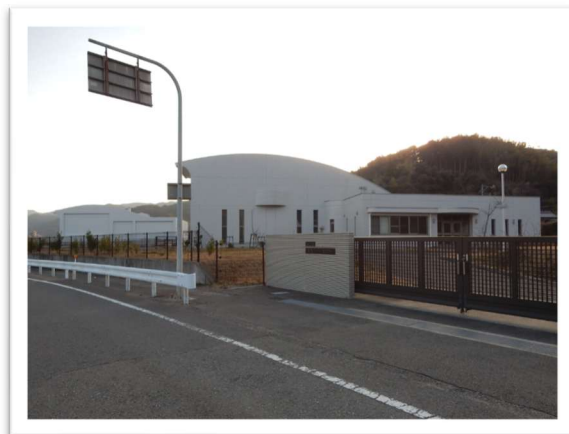
由良クリーンセンター
