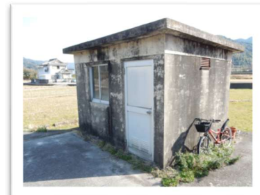
東条頭首工操作室
