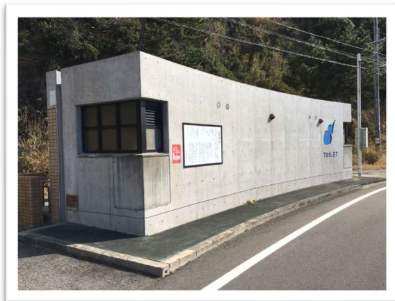
白崎万葉公園公衆トイレ
