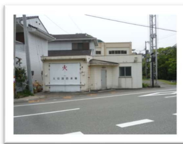
大引消防車庫
