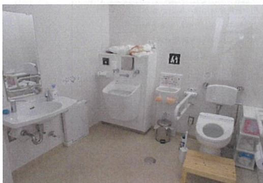
平成 30 年度 由良小学校 多目的トイレ整備
