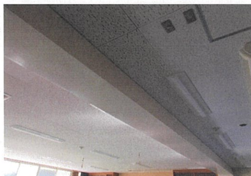
平成 30 年度 衣奈小学校 校舎 LED 照明器具取替
