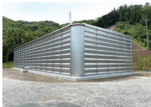
新 只越配水池（現在工事中）
